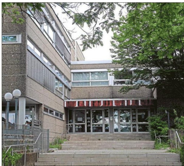
Vorschlag der Experten: Für ein Niedertemperaturnetz müsste in einem Anbau der Heinz-Barth-Schule eine Heizzentrale entstehen. Foto: jodo
