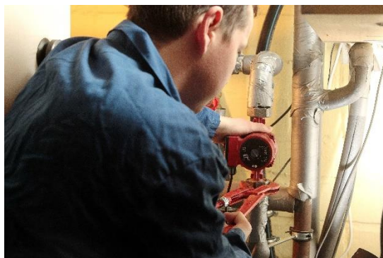
Einbau einer neuen Pumpe im Heizkreis. Quelle: www.co2online.de / Alois Müller
